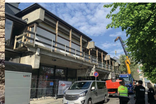
Renoveringen av Stenersen, KODE 2, ble ferdigstilt sommeren 2019. Salene er blant annet åpnet helt opp og vinduene skiftet ut.
